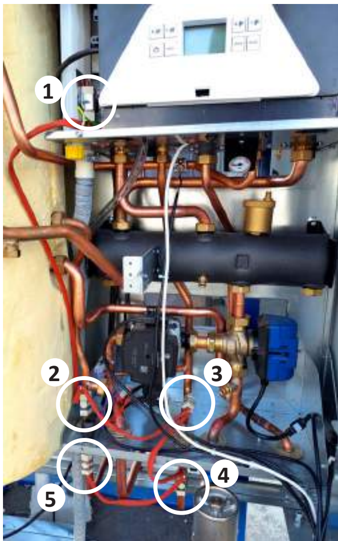
Resistenze antigelo a grappolo (5 elementi) nell'Unità Ibrida: 1 sul sifone condensa del modulo termico, 2-3 preinstallati di serie sui tubi acqua sanitaria interni dell'Unità, 4-5 da agganciare ai raccordi di collegamento idraulico acqua sanitaria.
