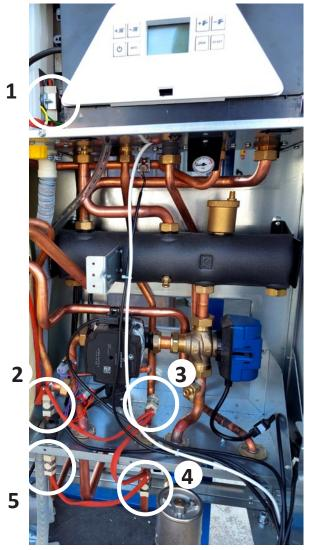
Resistenze antigelo a grappolo (5 elementi) nell'Unità Ibrida: 1 sul sifone condensa del modulo termico, 2-3 preinstallati di serie sui tubi acqua sanitaria interni dell'Unità, 4-5 da agganciare ai raccordi di collegamento idraulico acqua sanitaria.
