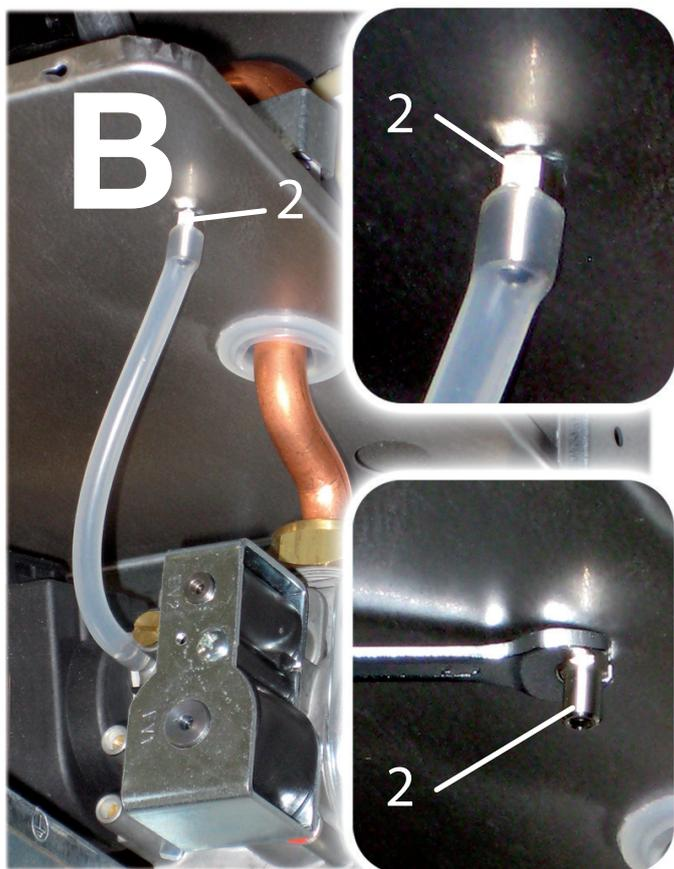
**Sostituire il vent della camera stagna** con quello nella busta (**figura B, pos. 2**).
